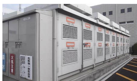
図2 浮間水再生センターの太陽光パネルとNaS電池 出典；筆者撮影
