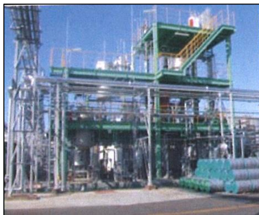
図15 住友ベークライトのフェノール樹脂の超臨界熱分解実証プラント
